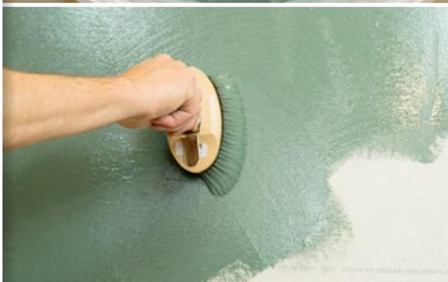
8. Pigmente in Kreidezeit Wandfarben und Putzen hellen erheblich während des Trocknens auf. Links, frisch aufgetragene Farbe, rechts getrocknete Farbe in derselben Pigmentierung.
