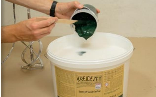
6. Mit einem Rührgerät die Pigmentmischung in die Farbe gleichmäßig einrühren.
